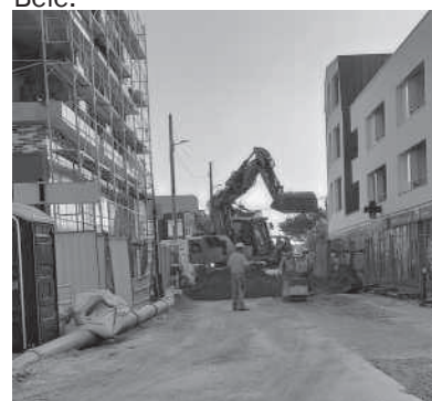
Travaux route de saint-joseph
