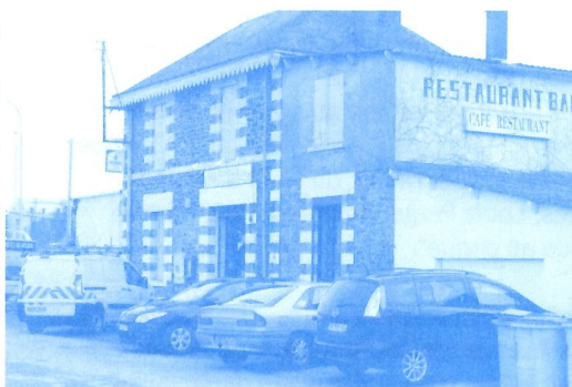
Le restaurant de la gare, aux Batignolles, va disparaître
