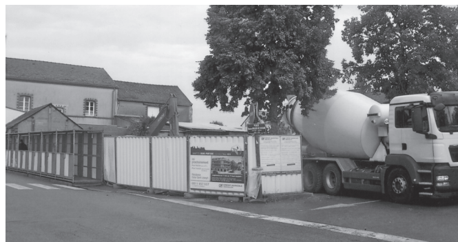
l'immeuble en construction
