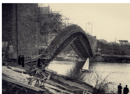
Photo : 1944, les coffrages du nouveau pont
