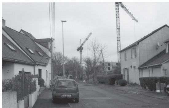
Le chemin des Garniers débouche sur le chantier
