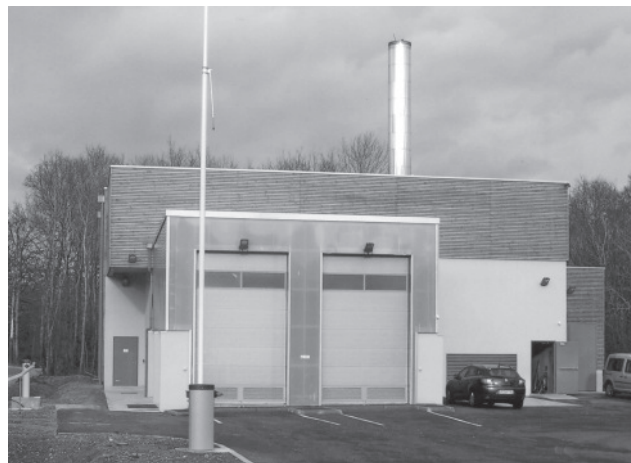
La chaufferie à bois de la Chantrerie
