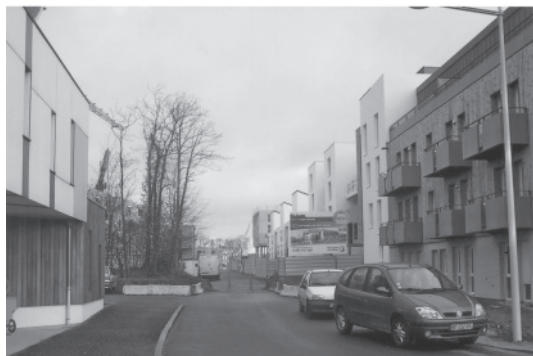
La rue de la Planche au Gué, axe principal du quartier en construction
